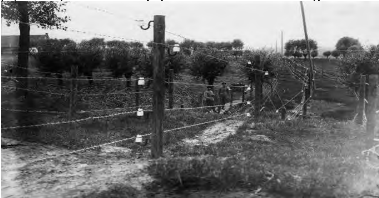
Рисунок 2 – Первые системы электризуемых заграждений
