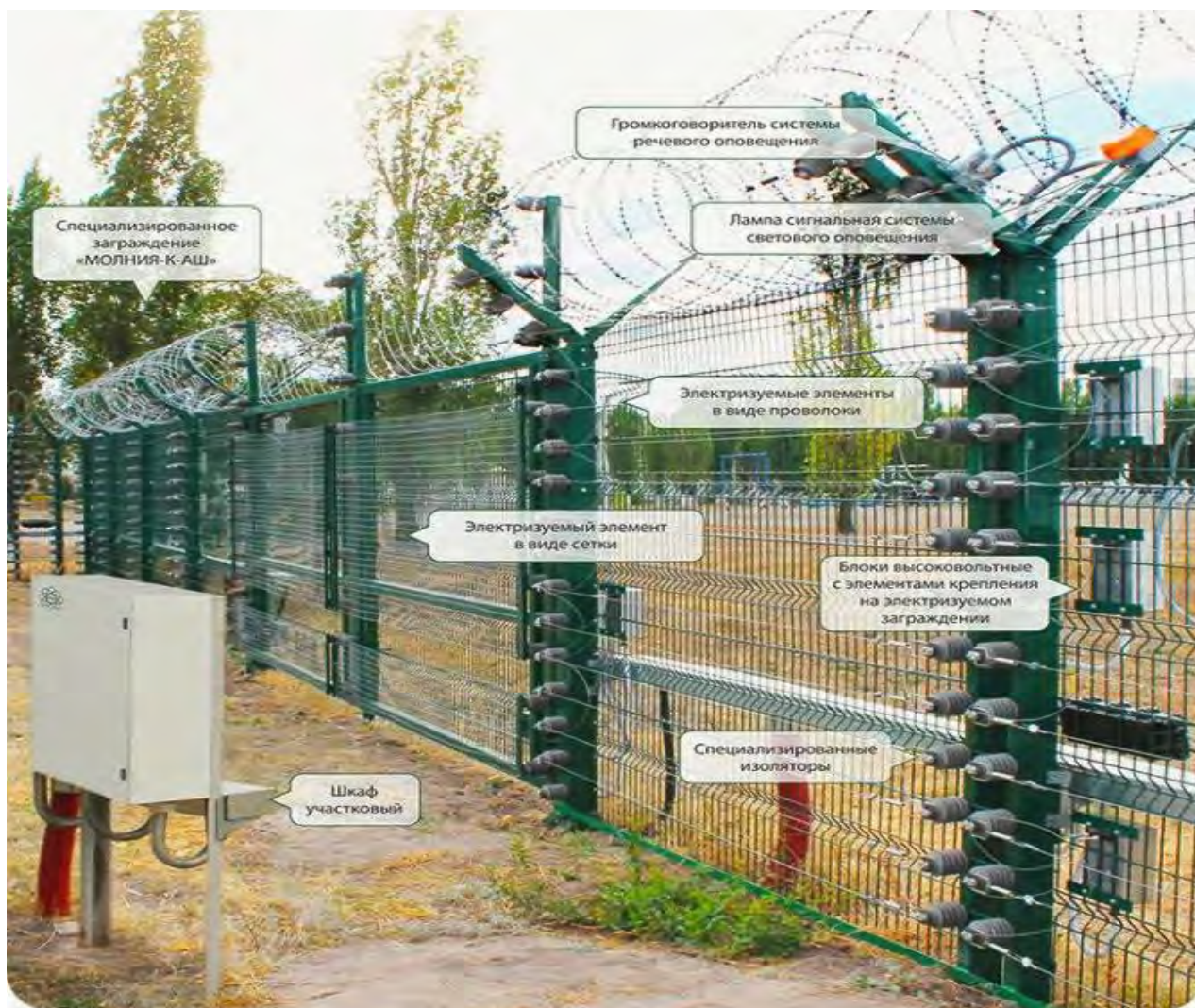
Рисунок 1 – Вариант использования электризуемых заграждений для контроля доступа к объекту
