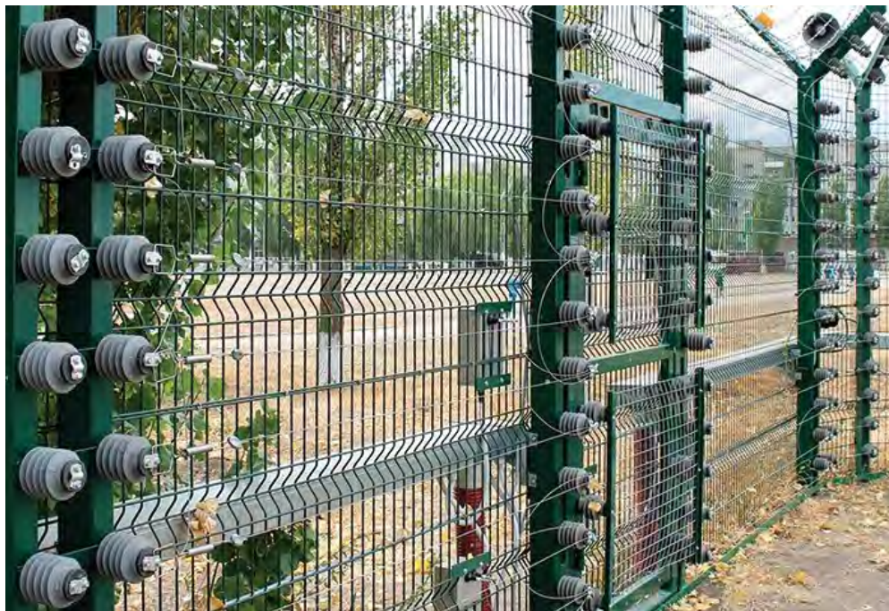
Рисунок 4 – Мобильное электризуемое ограждение компании «Молния»
