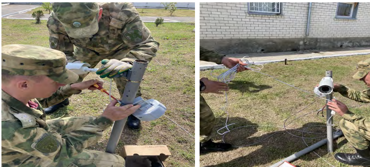
Рисунок 6 – Крепление видеокамеры на штангу
