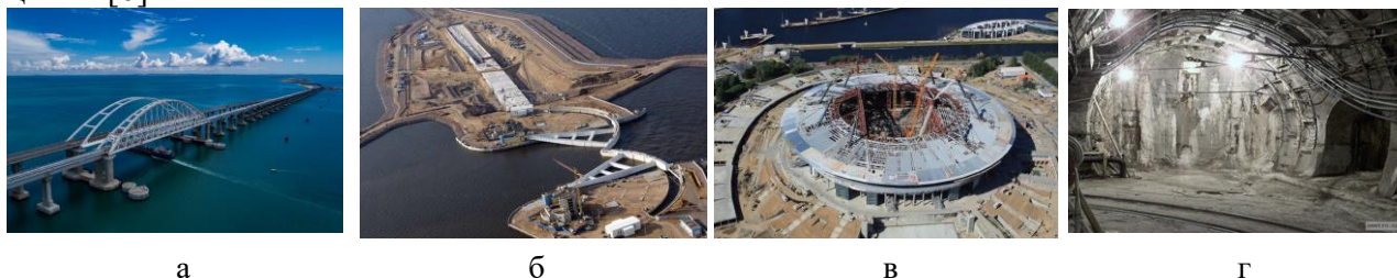
Рисунок 1 – Здания и сооружения, подлежащие оснащению системами мониторинга: а – мосты; б – гидросооружения; в – уникальные сооружения; г – специальные фортификационные сооружения
